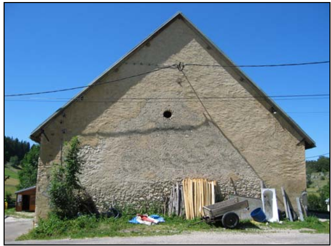
2 enduits jetés recoupés d'un pignon surélevé
