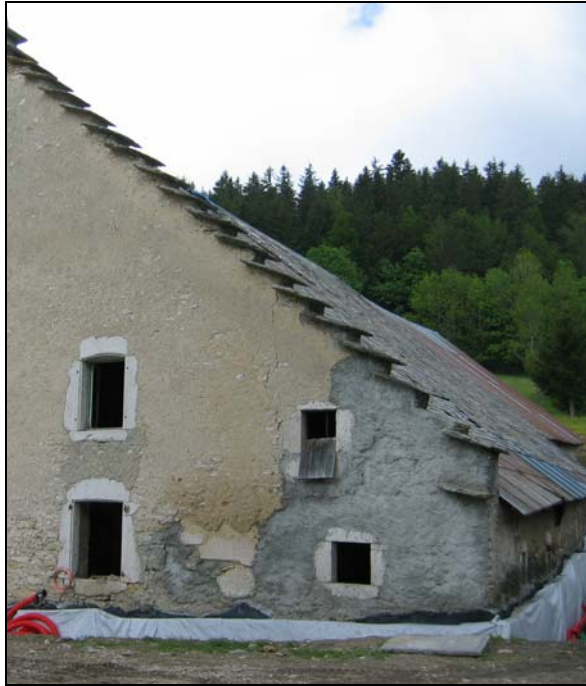
Méandre (anciennes reprises de maçonneries au ciment)
