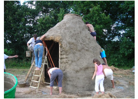
Enduits en Terre
