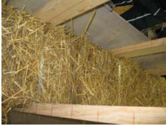
Figure 2.1 : Structure bois avec remplissage paille et feuillards
