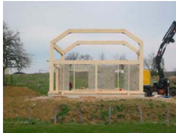
Figure 2.7 : Portique tridimensionnelle de la maison de Montholier
