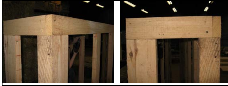
Figure 3.3 : Photos des assemblages de planches sur la lisse haute
