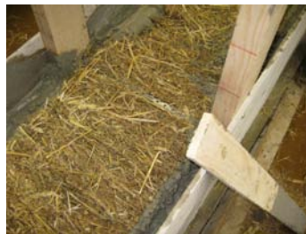
Figure 2.3 : Mortier coulé contre les ballots de paille
